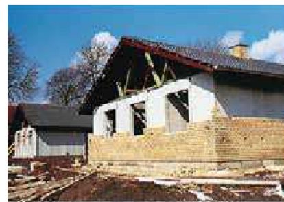
9. Eksempel på skalmuret typehus. Det indvendige og udvendige hus ses tydeligt. Efter Sven Bertelsen: Bellahøj - Ballerup - Brøndby Strand. 25 år der industrialiserede byggeriet.
